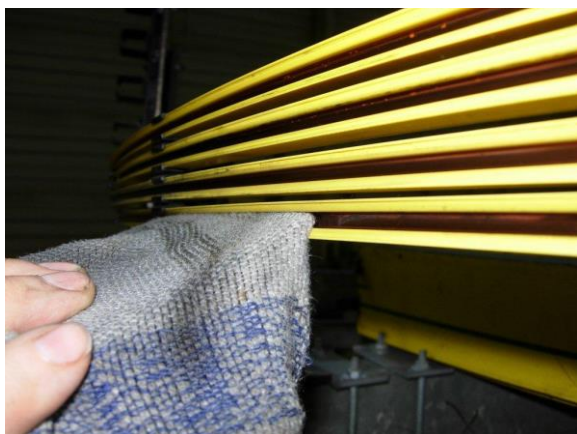
图 10:更改清洁工具间隙角，以清洁不同区域
