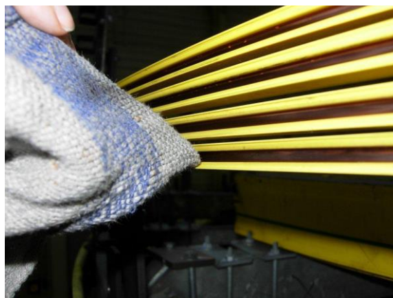
图 11:底部区域清洁间隙角
